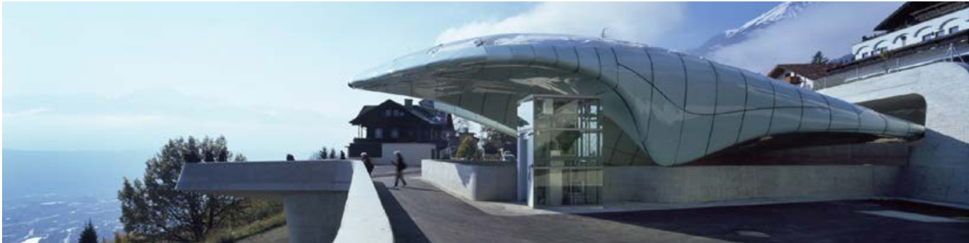
La funicolare Hangerburg di Innsbruck, progettata da Zaha Hadid
